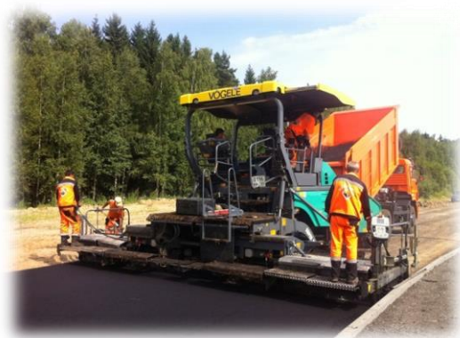
Рис. Машинист укладчика асфальтобетона
